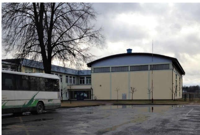
Zdjęcie nr 2: Plac przed budynkiem Szkoły służący jako miejsce postojowe
