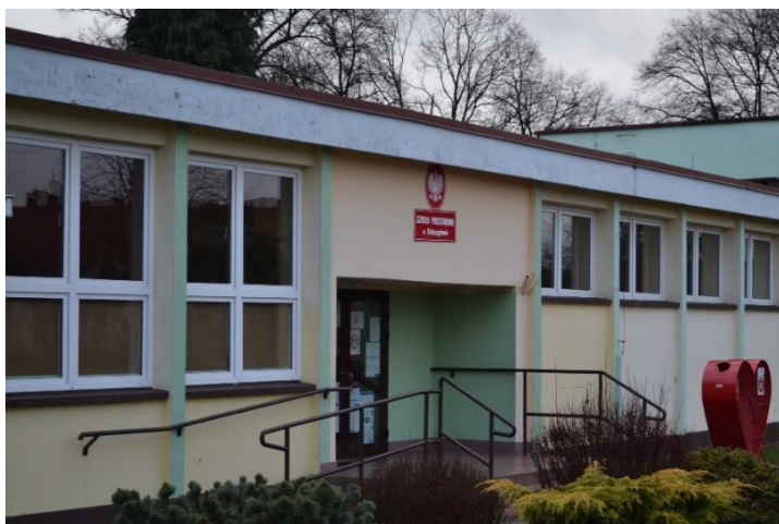
Zdjęcie nr 5: Wejście główne do starej części Szkoły
