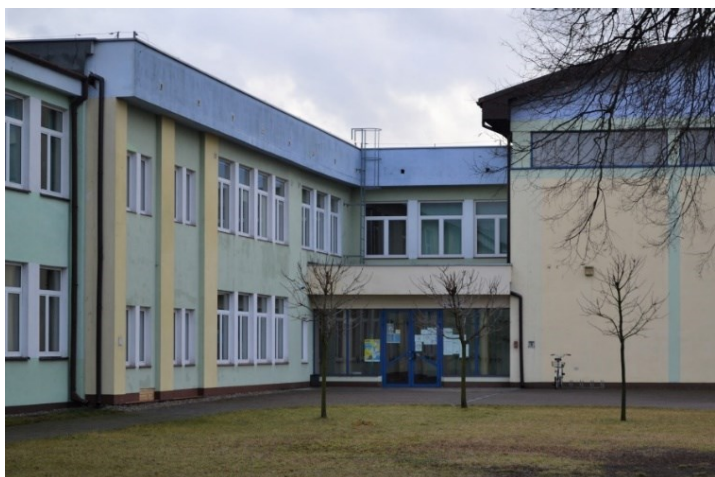
Zdjęcie nr 6: Wejście główne do dobudowanej części Szkoły
