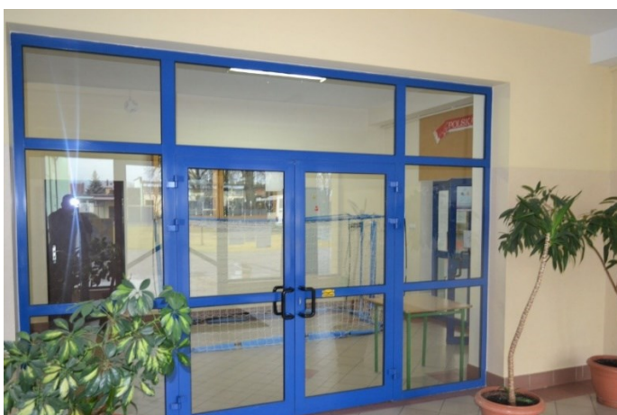
Zdjęcie nr 10: Widok z wejścia głównego w dobudowanej części Szkoły wraz z wejściem do sali gimnastycznej
