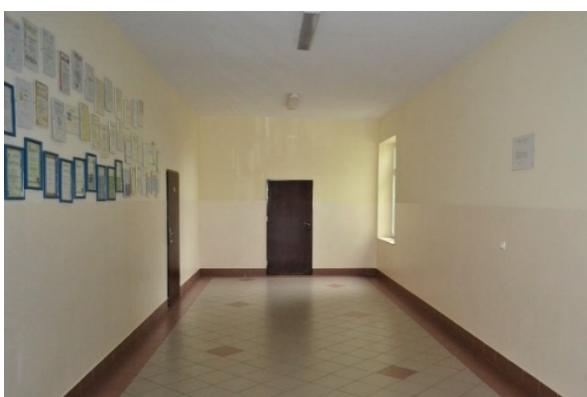
Zdjęcie nr 18: Posadzka z płytek ceramicznych na korytarzu piętra w nowej części Szkoły z widocznym kontrastem między ścianą a cokołem
