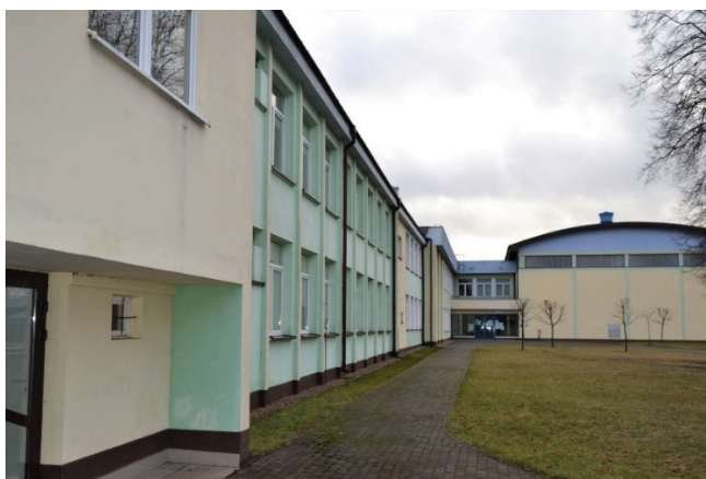
Zdjęcie nr 3: Utwardzony ciąg komunikacyjny wzdłuż ścian budynku prowadzący do wejścia głównego i bocznego Szkoły
